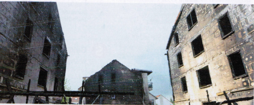
Helmenhorst bei Bremen: Das Dämmmaterial hatte den Brand beschleunigt. In fünf Häusern wurden im Juni 2011 zerstört
